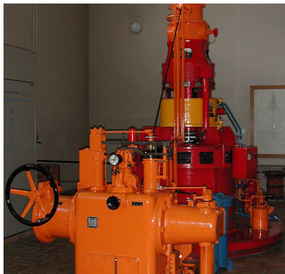
Turbinenregler / Generator
