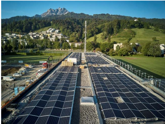
Die Solaranlage auf dem Dach des neuen Fussballstadions des SC Kriens produziert sauberen regionalen Strom.
