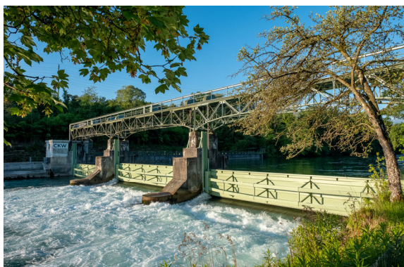
Über das Winterhalbjahr hat CKW das Stauwehr des Wasserkraftwerks Rathausen saniert.
