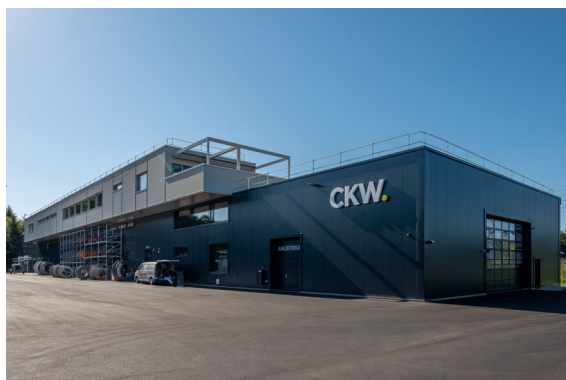
CKW hat im Frühjahr 2020 den neuen Werkhof in St. Erhard in Betrieb genommen.
