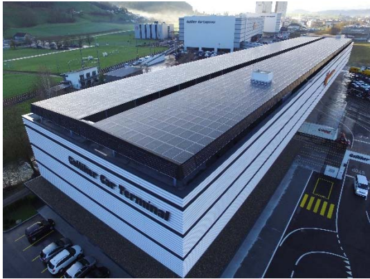
4000 m 2 gross ist die PV-Anlage bei Galliker Transport.
