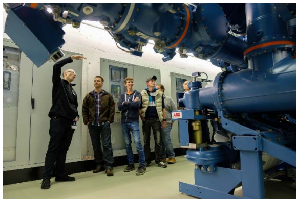
Bei technischen Anlagen wie beispielsweise einer Unterstation sind bei Löscheinsätzen besondere Vorkehrmassnahmen nötig.
