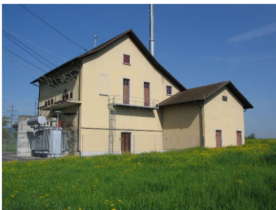
Die 1953 gebaute Unterstation Hochdorf wird bis Herbst 2021 durch einen Neubau ersetzt.
