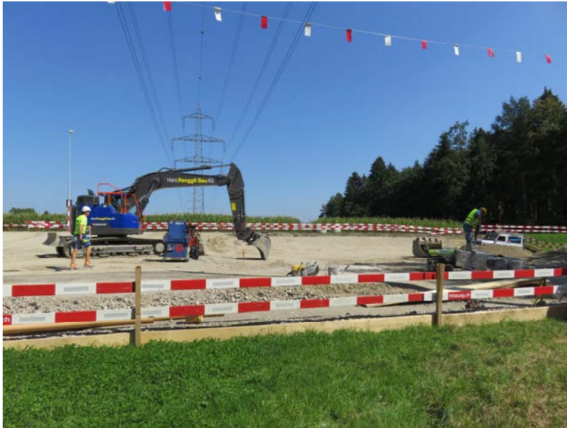
Im Industriegebiet von Rothenburg entsteht die neue Unterstation von CKW.
