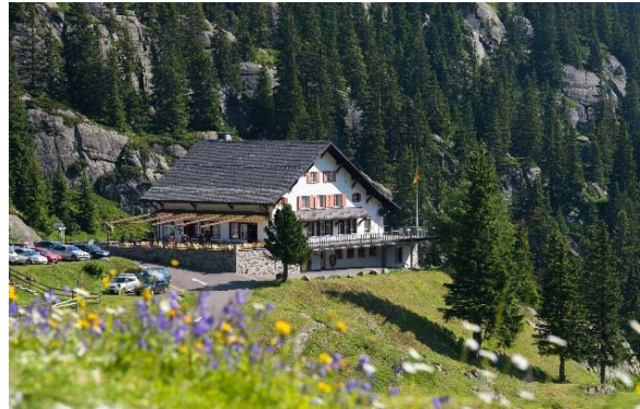
Das Berggasthaus Dammagletscher auf der Göscheneralp wird in den nächsten Jahren sanft renoviert.
