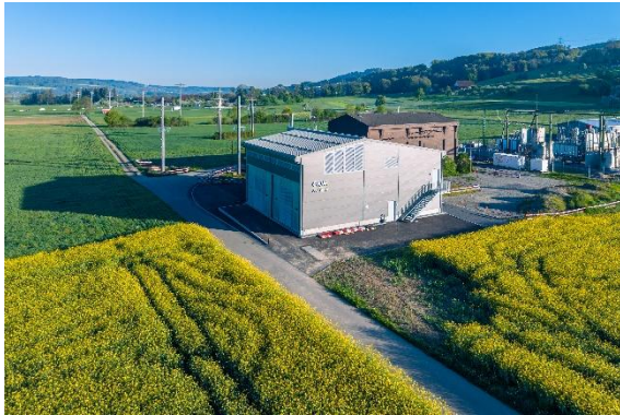
CKW hat das Unterwerk Sursee erneuert. Es stärkt langfristig die Versorgungssicherheit in der Region.
