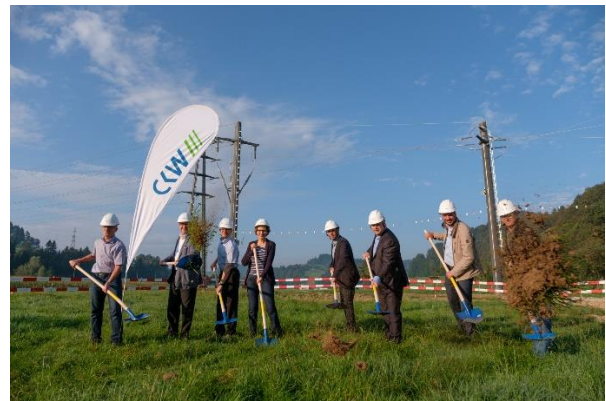
Strahlende Gesichter: Das erste Stück Erde ist ausgehoben.
