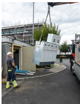
Ausbau einer Trafostation
