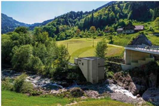
Visualisierung der Kraftwerkszentrale unterhalb der Chrutacherbrücke in Flühli. Ab hier fliesst das entnommene Wasser zurück in die Waldemme und durch die Lammschlucht.
