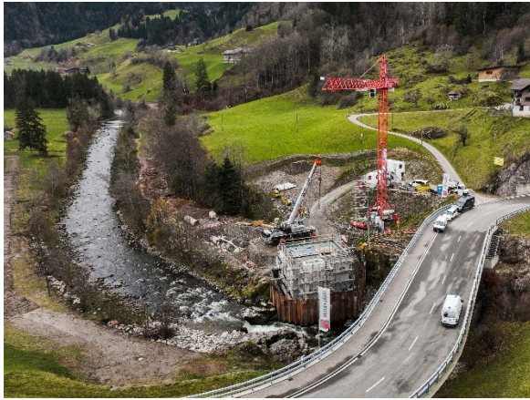
In diesen Tagen wurden beim neuen Wasserkraftwerk Waldemme in Flüeli die Turbine und der Generator angeliefert und eingesetzt.
