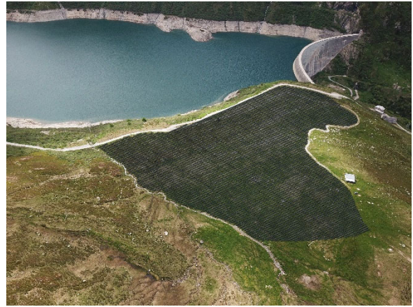
CKW treibt den Ausbau der erneuerbaren Energien voran. Unter anderem auch mit Solaranlagen im alpinen Raum.
