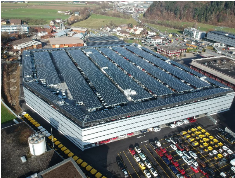
CKW installierte 2020 in Altishofen die grösste Carport-Solaranlage der Zentralschweiz. Sie wurde mit dem Schweizer Solarpreis ausgezeichnet.
