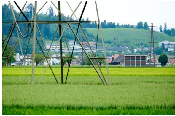
Das neue Unterwerk wird an das ganz in der Nähe vorbeiführende nationale Höchstspannungsnetz von Swissgrid (im Vordergrund ein entsprechender Masten) angebunden.
