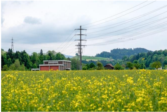
Die 40-jährige Unterstation Willisau wird durch einen Neubau ersetzt.
