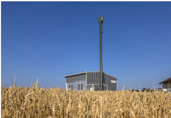
Die neue CKW-Unterstation Hochdorf.
